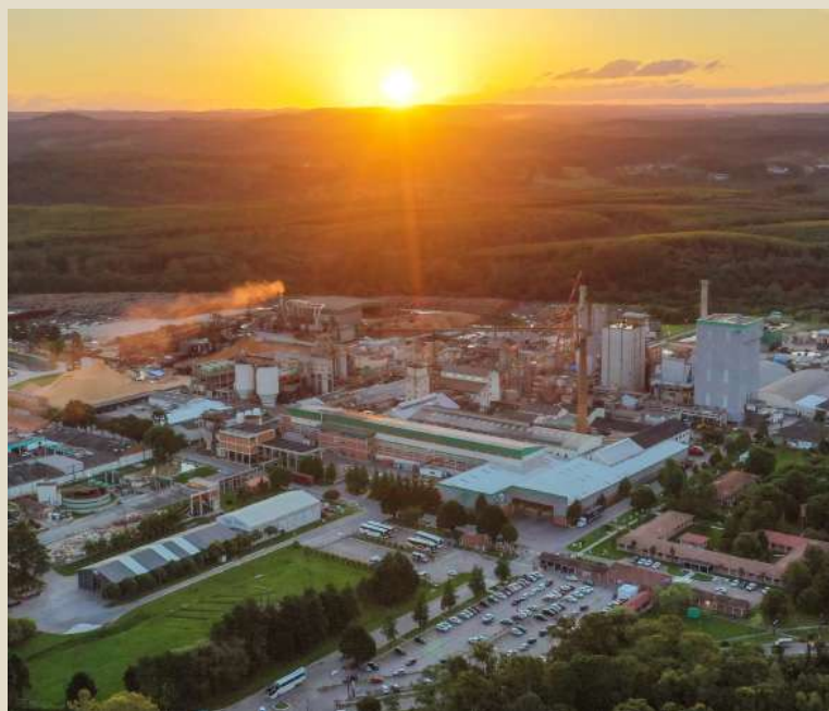
Vista aérea da Unidade Otacílio Costa (SC)
